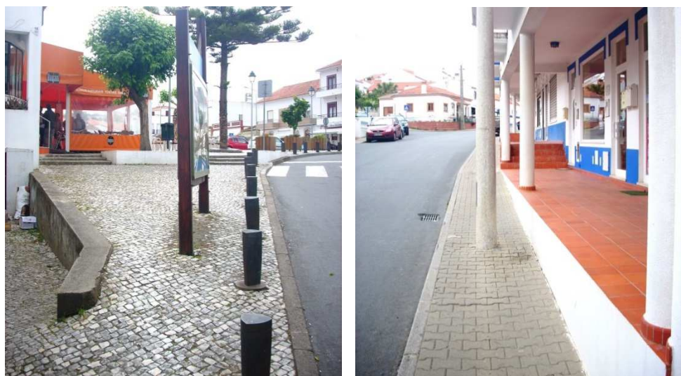
Figura 10 - Exemplos de obstáculos e de barreiras arquitetónicas no Largo Gomes Freire (esq.) e na Rua do Passal (dta.)
