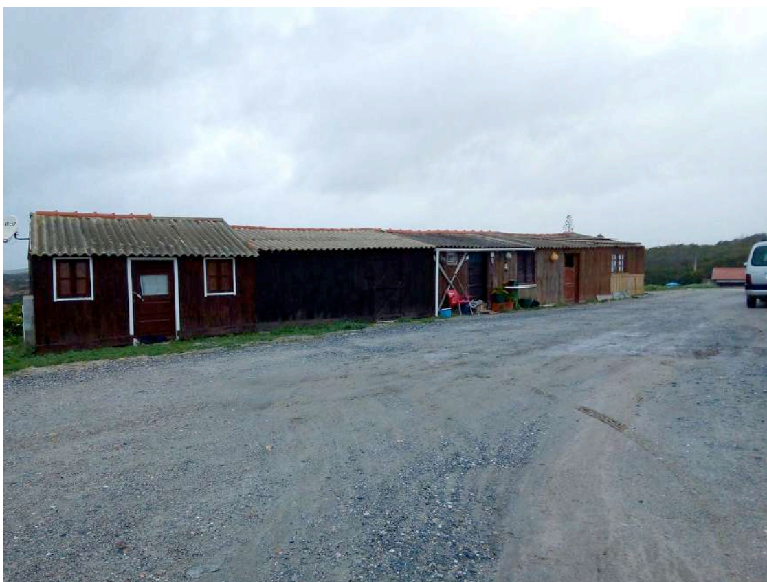
Foto n.º 8 – Construções de carácter precário no aglomerado norte de barracas de Entrada da Barca.
