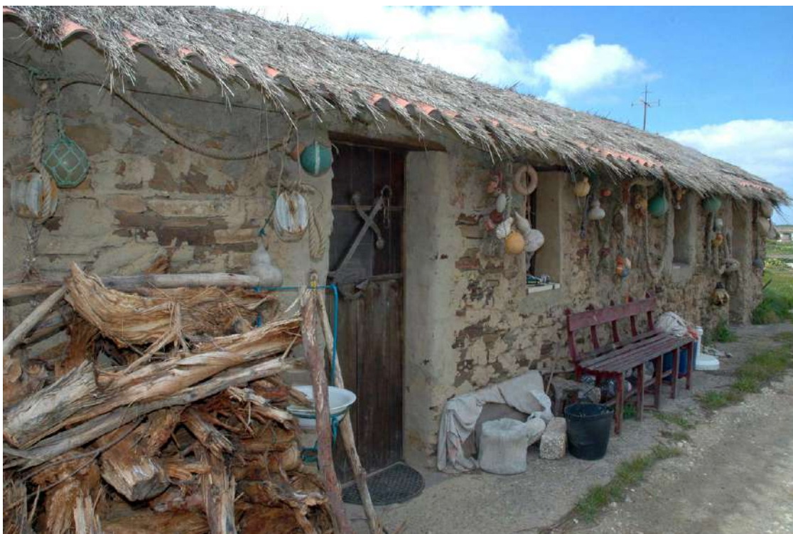
Foto n.º 12 – Casa junto ao Posto Fiscal com alvenaria de pedra e falsa cobertura de estorno sobre telhado de fibrocimento, final da década de 2000 (fotografia de João Mendes, CMO).
