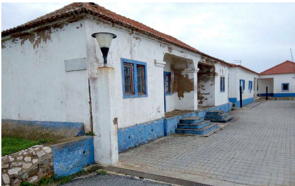
Foto n.º 13 – Edifício da década de 1920, actualmente devoluto, na entrada do recinto do Posto Fiscal do Sardão.
