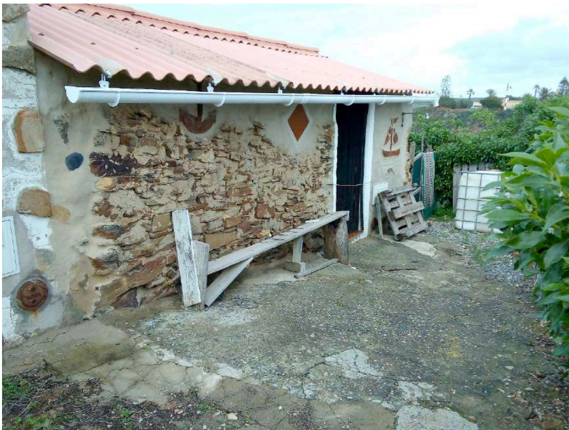
Foto n.º 11 – Estado actual da casa fotografada na década de 1960, com a alvenaria de pedra de xisto original sob revestimento cimentício.
