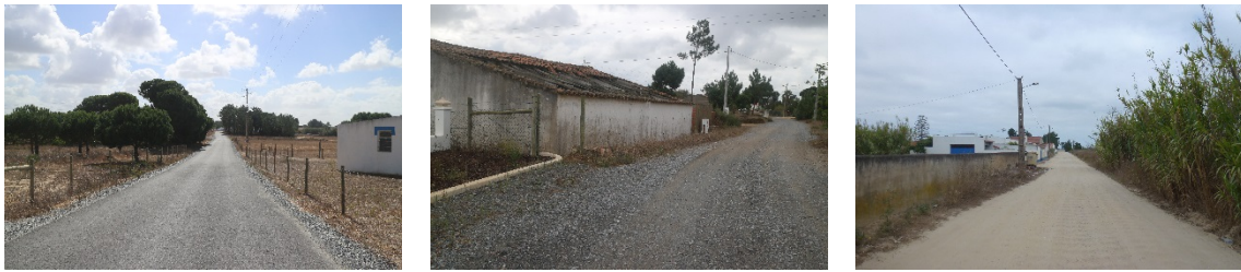
Figura 11: Exemplificação do tipo de pavimento: asfalto (esquerda), brita graduada (centro) e terra batida (direita)
