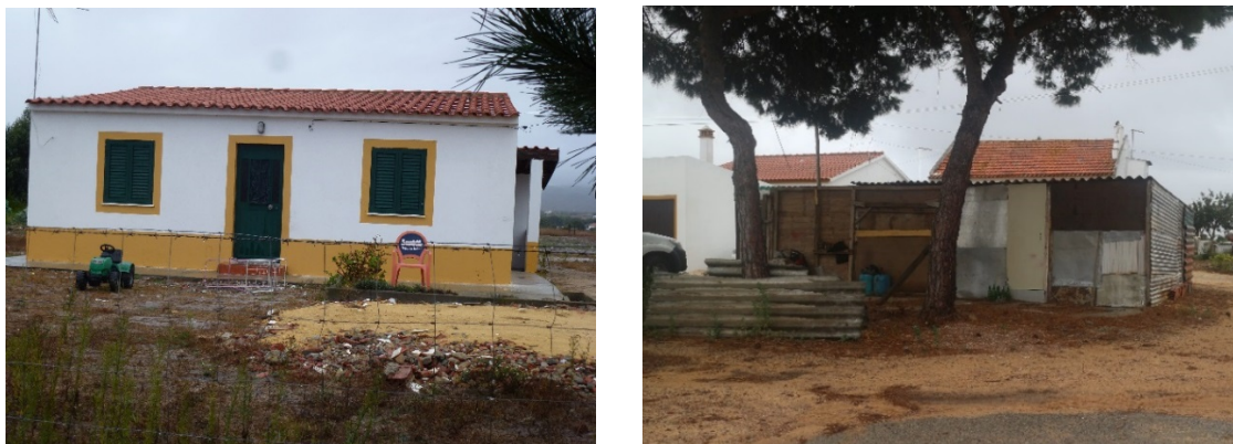
Figura 8: Exemplo de revestimento exterior de reboco pintado (à esquerda) e de aço/alumínio (à direita)
