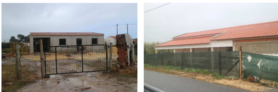
Figura 9: Exemplo de edifício em construção (à esquerda) e em obras (à direita)
