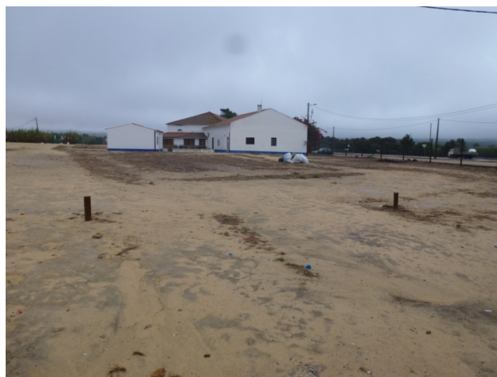
Figura 19: Associação Cultural, Desportiva e Recreativa das Brunheiras e espaço do mercado das Brunheiras
