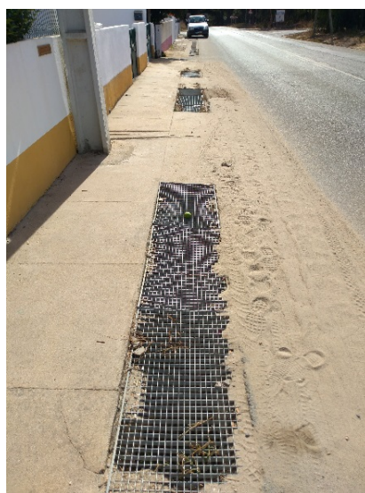
Figura 13: Exemplificação dos passeios existentes em Foros do Galeado
