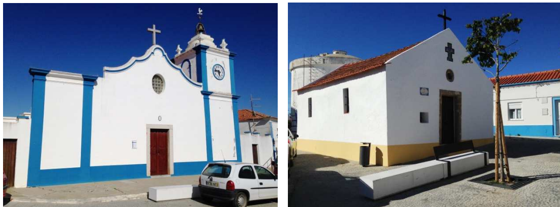
Figura 10 – Igreja Matriz (esq.) e Ermida de São Sebastião (dir.).
