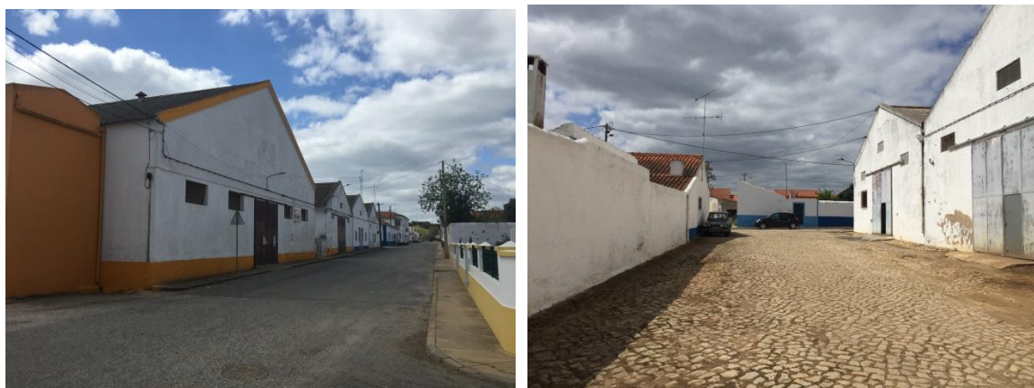
Figura 3 - Imagens de edifícios de carácter industrial / logístico.
