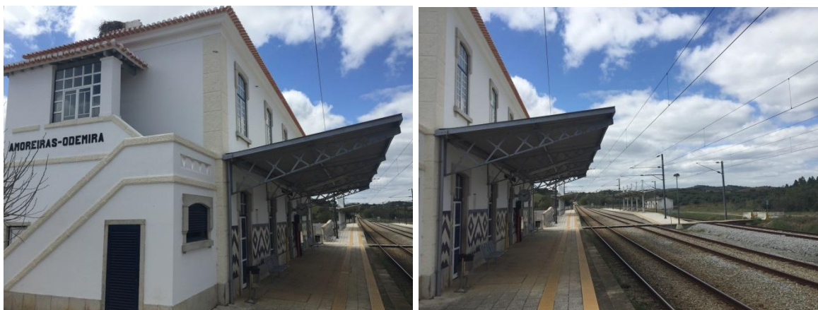
Figura 2 - Imagens do edifício da estação de ferroviária.
