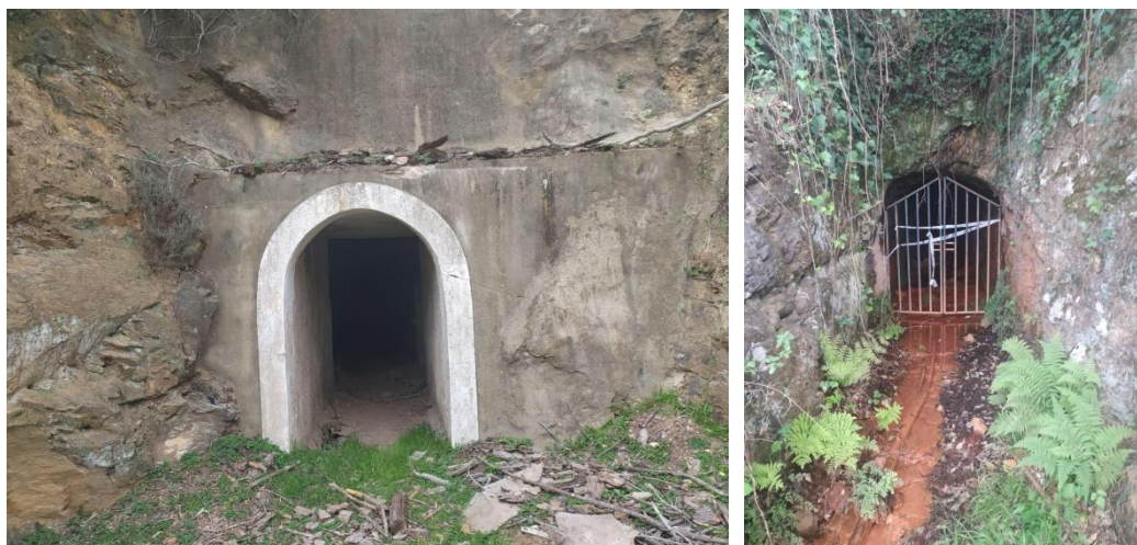
Entradas da Mina de Rosalgar
