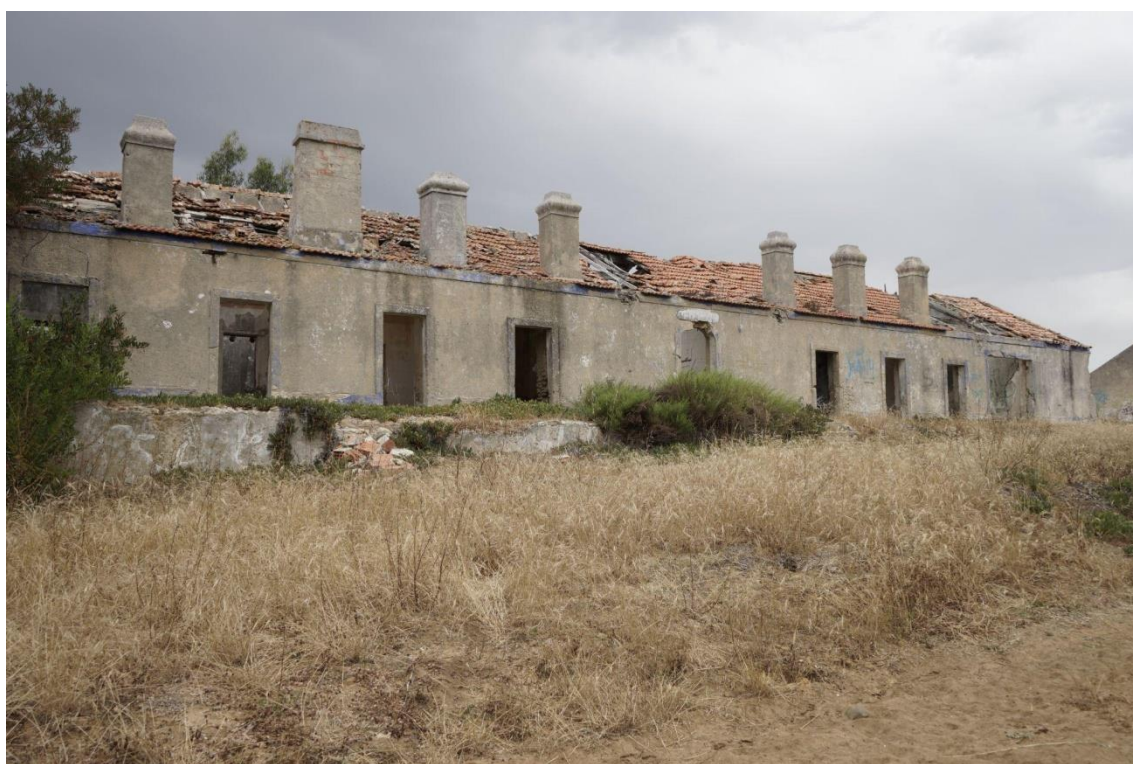
Pousadas Novas - Habitação dos trabalhadores
