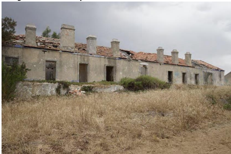
Figura 21: Edifício para trabalhadores em Pousadas Novas
