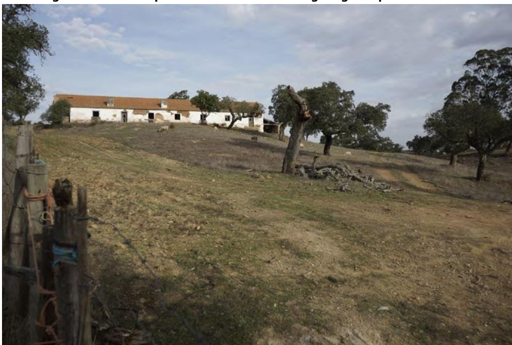
Figura 24: Edifício para trabalhadores em Reguengo Pequeno “Pedreira”
