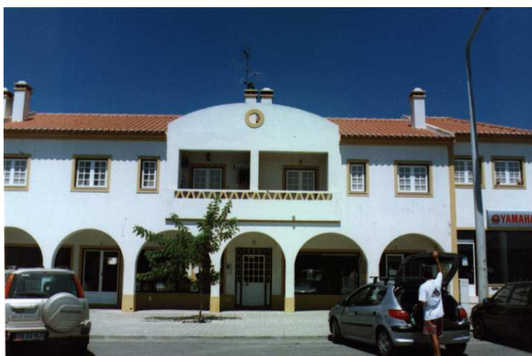
Fotografia 3 - Vista de um dos Apartamentos – ficha n.º 32-A
