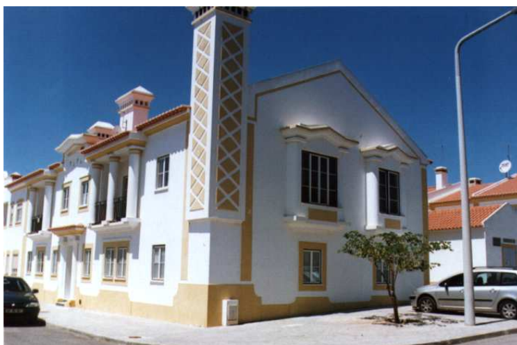
Fotografia 2 – Vista de um dos Apartamentos – ficha n.º 27
