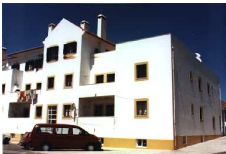
Fotografia 4 - Vista de um dos Apartamentos – ficha n.º 41
