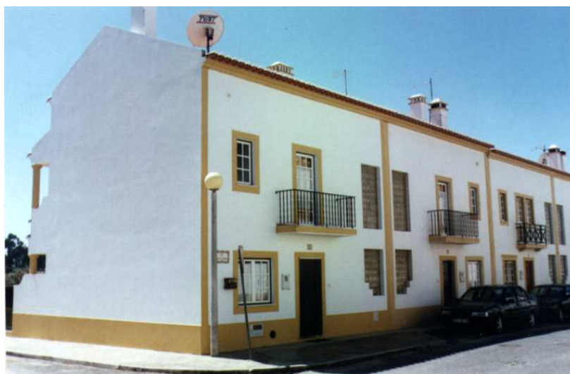
Fotografia 5 - Vista de um dos Apartamentos – ficha n.º 41
